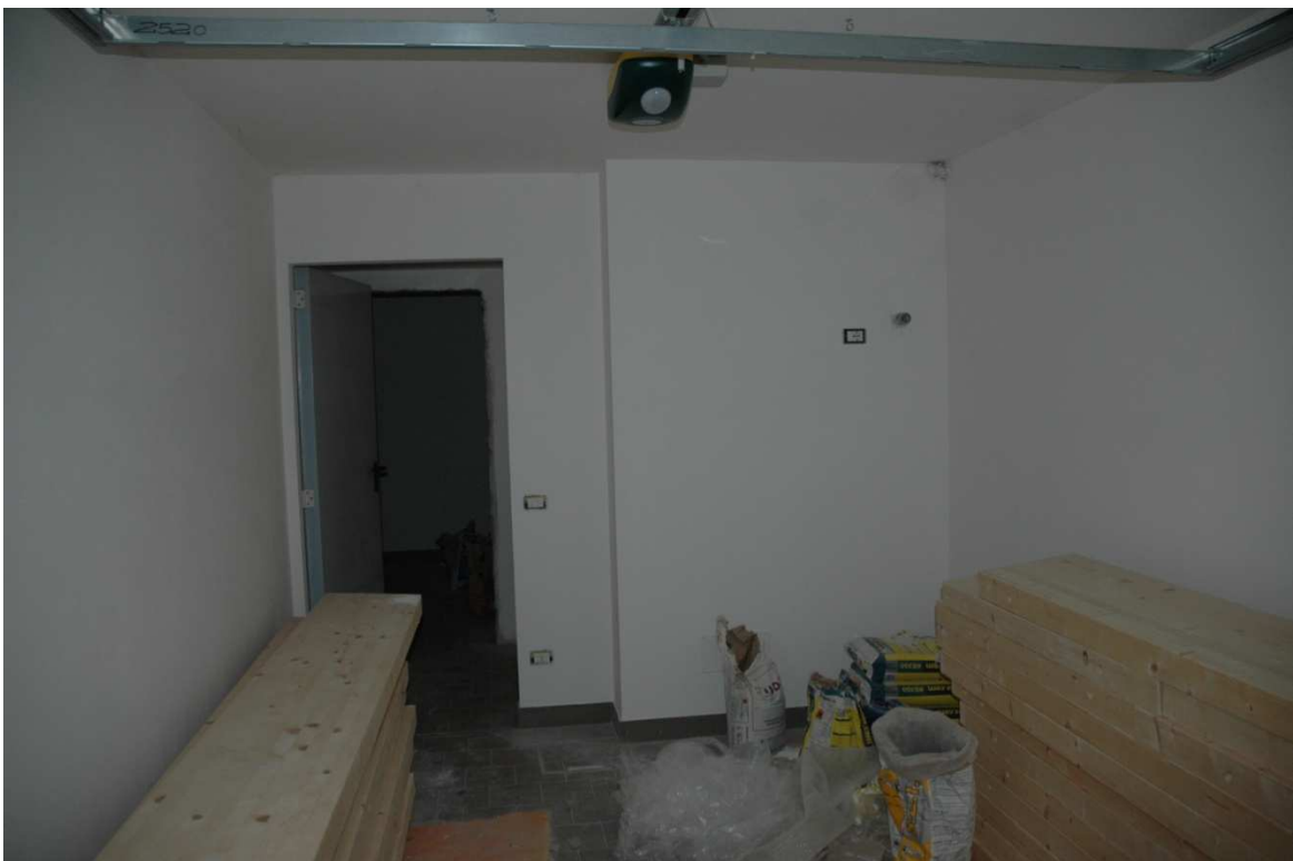
Foto 45 - Il pavimento è in gres.
