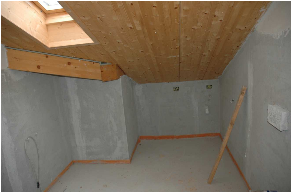
Foto 56 - Il tetto è in legno con rivestimento di assito a pannelli.
