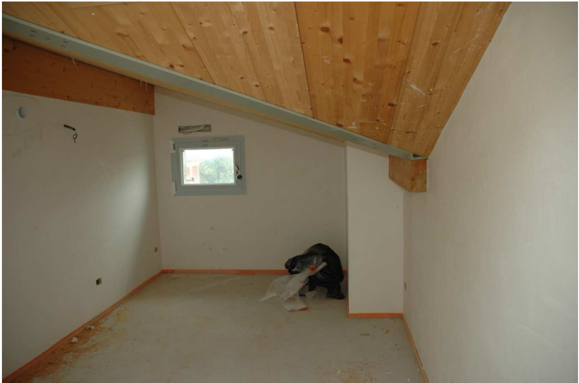
Foto 67 – Al piano sottotetto, una finestra e la predisposizione degli impianti.
