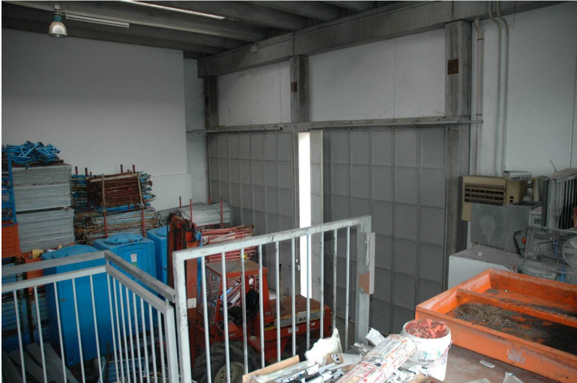
Foto 92 – Vista del deposito dalla zona soppalco, sopra gli uffici.
