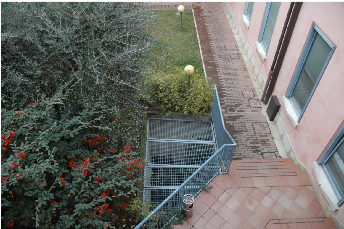
Foto 23 - Sul terreno si nota la bocca di lupo del piano interrato protetta da grata in ferro.
