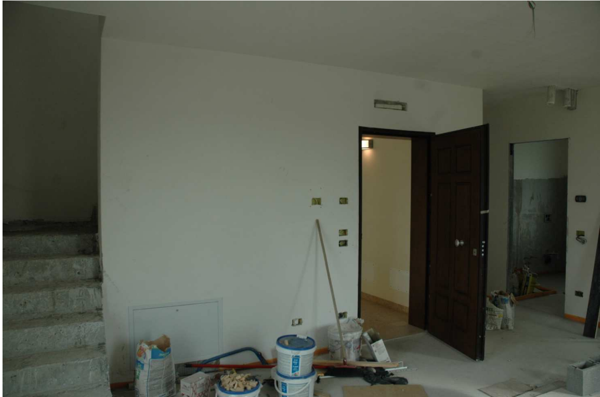
Foto 37 - La scala porta al piano sottotetto, il portoncino è del tipo blindato.
