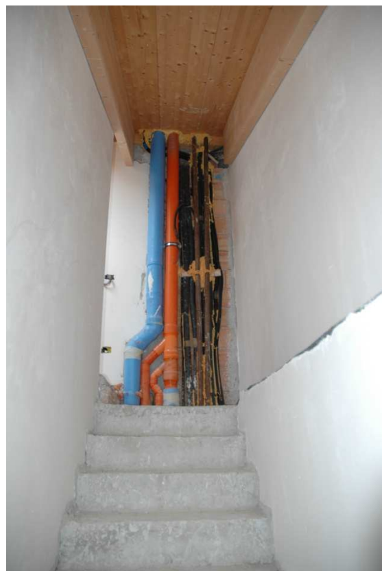
Foto 58 - La scala in muratura porta al sottotetto.
