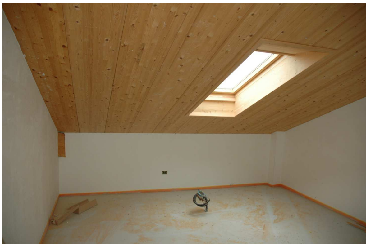
Foto 69 – Sul tetto lucernari con vetro camera.
