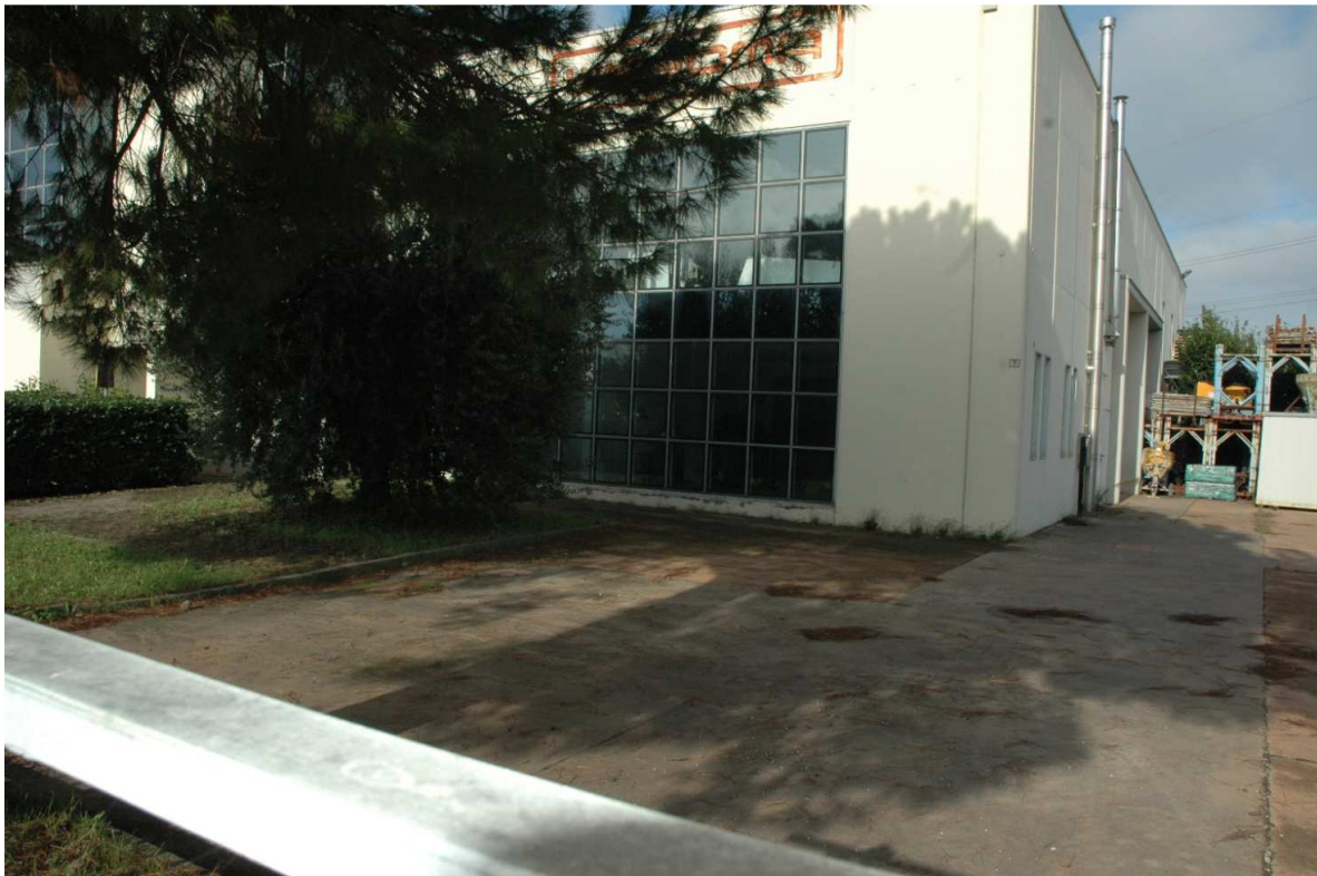
Foto 91 – Ampio parcheggio interno e accesso alla zona deposito, sulla destra.
