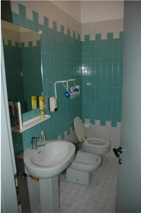
Foto 18 - Servizio con rivestimento sulle pareti.
