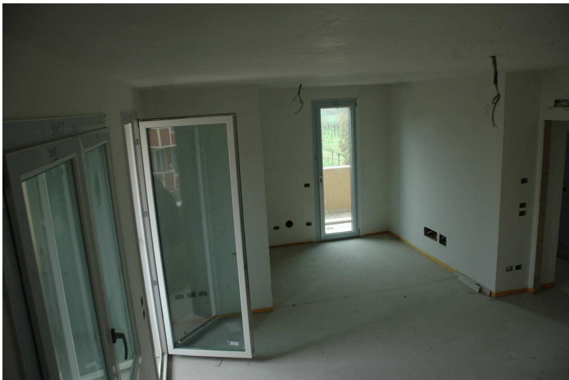
Foto 48 - Appartamento con ampie aperture sulla zona giorno. Da completare mancando porte, pavimenti, completamento degli impianti.
