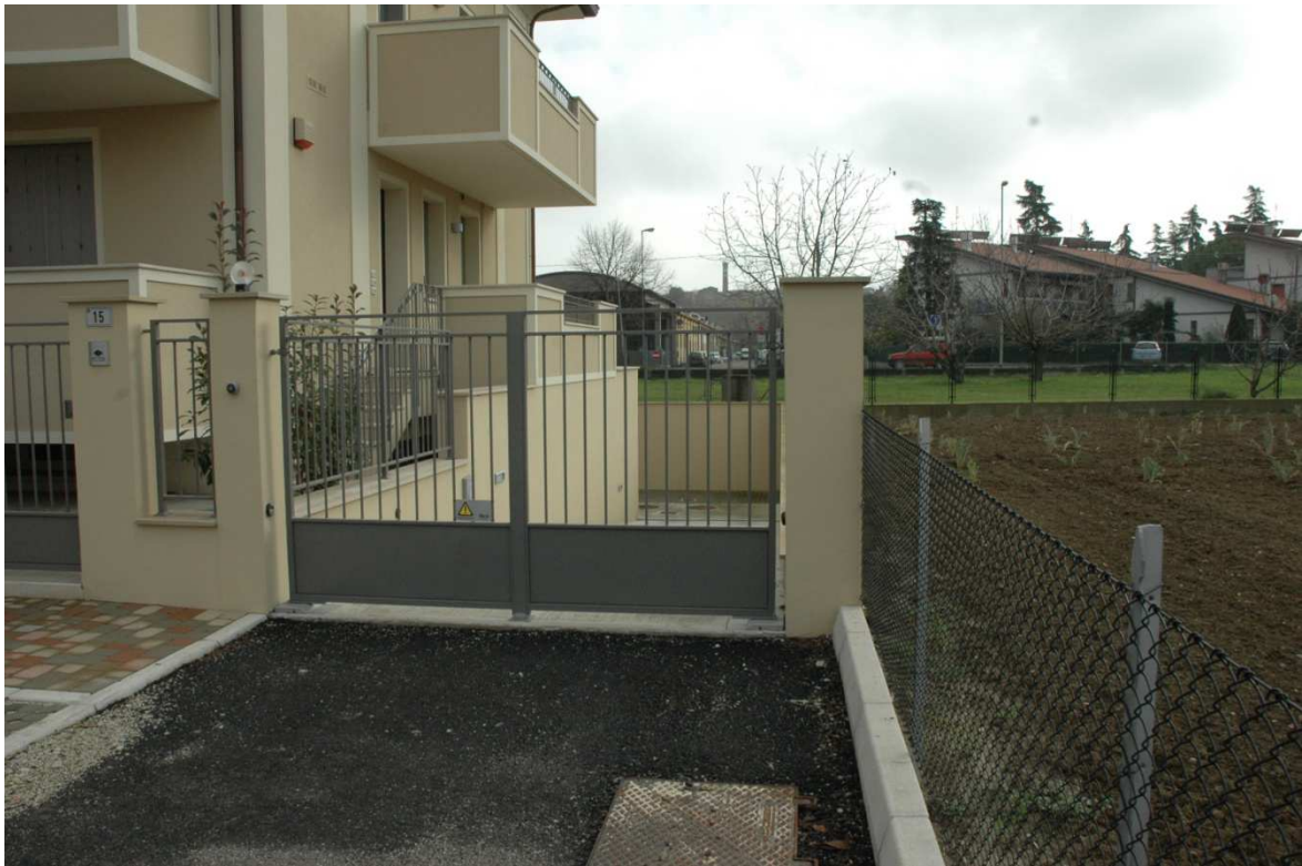
Foto 41 - Ingresso al piano interrato dove si trovano i garage.
