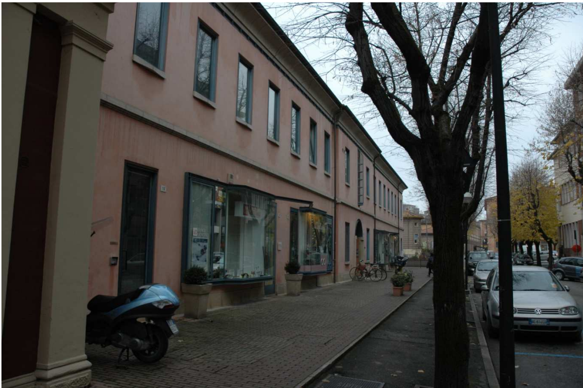
Foto 2 - Sulla destra della ex cappella al piano primo l'ufficio che si affaccia sulla via Dante di Nanni.
