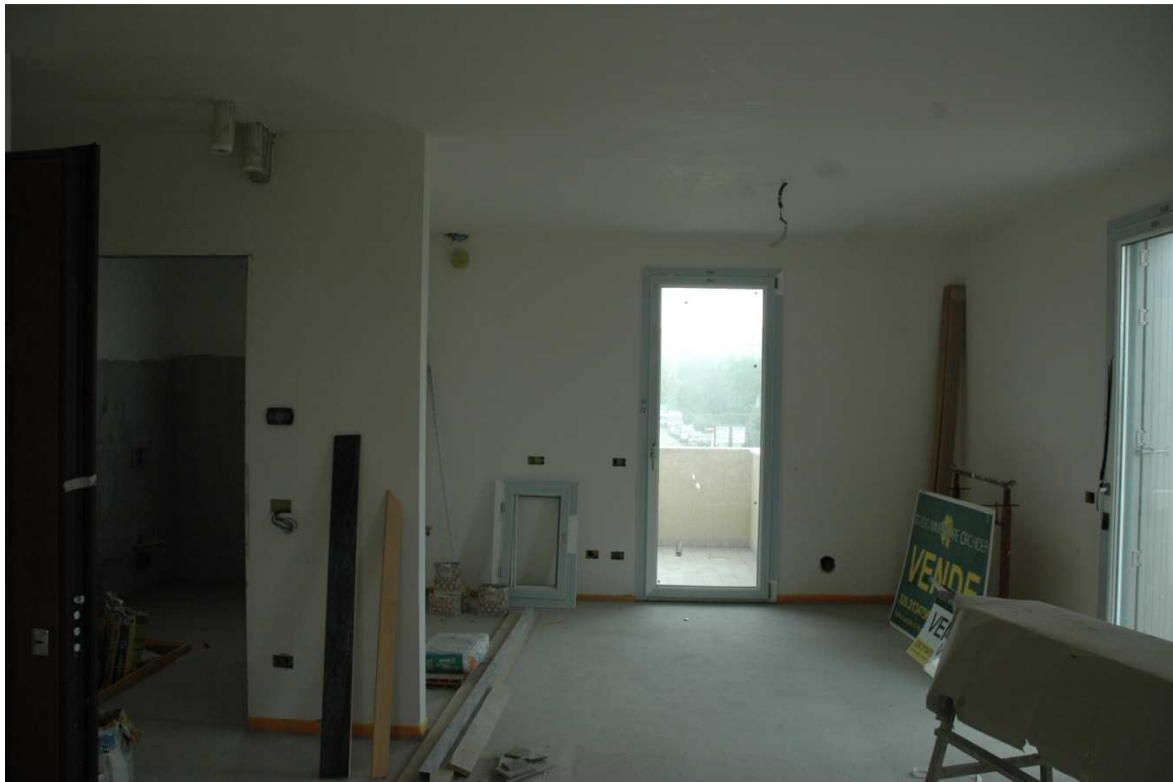
Foto 36 - L'appartamento è da completare mancano: le porte, i pavimenti, il completamento degli impianti, la tinteggiatura; la stima ha tenuto conto del completamento assegnando € 100/mq. in riduzione del prezzo.
