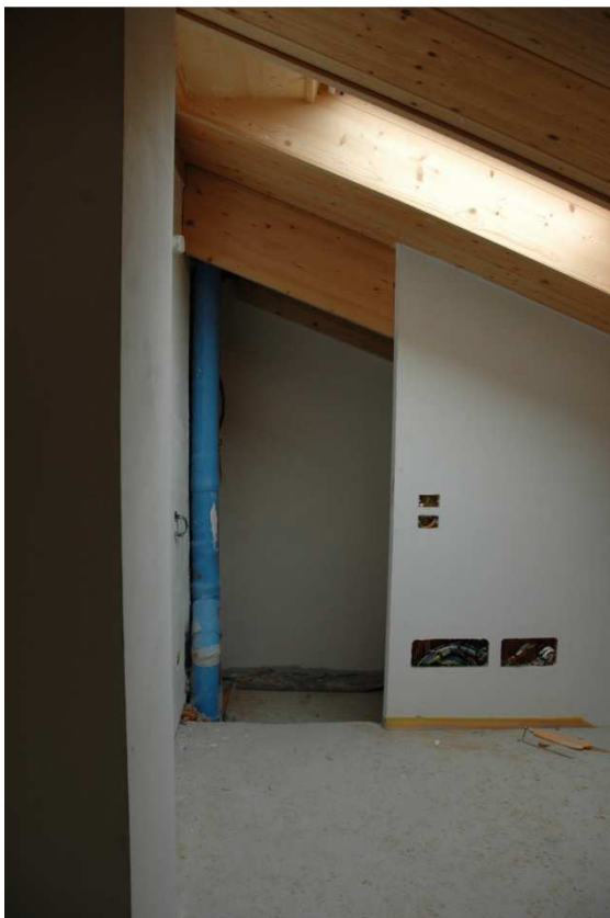
Foto 57 - Nelle porzioni più basse sono stati ricavati dei ripostigli.
