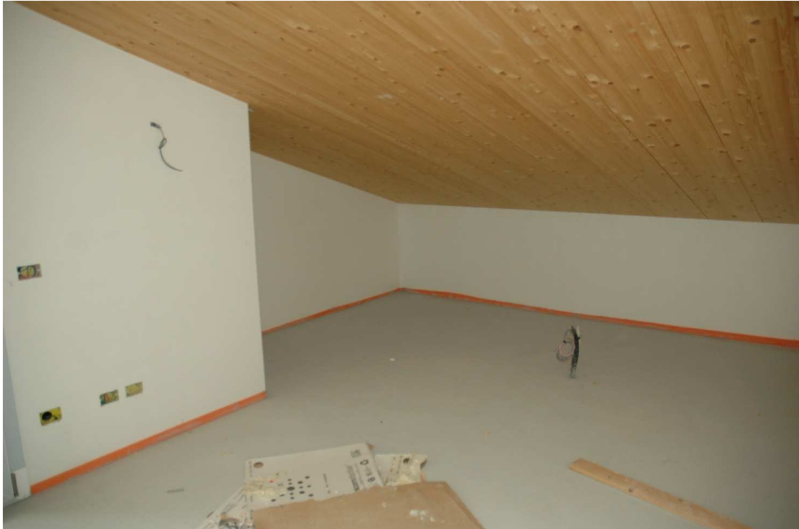
Foto 39 - Nel sottotetto diversi ambienti "soffitta", predisposti per essere utilizzati anche come camere da letto. Il riscaldamento è a pavimento con pannelli radianti, il tetto in legno a vista.
