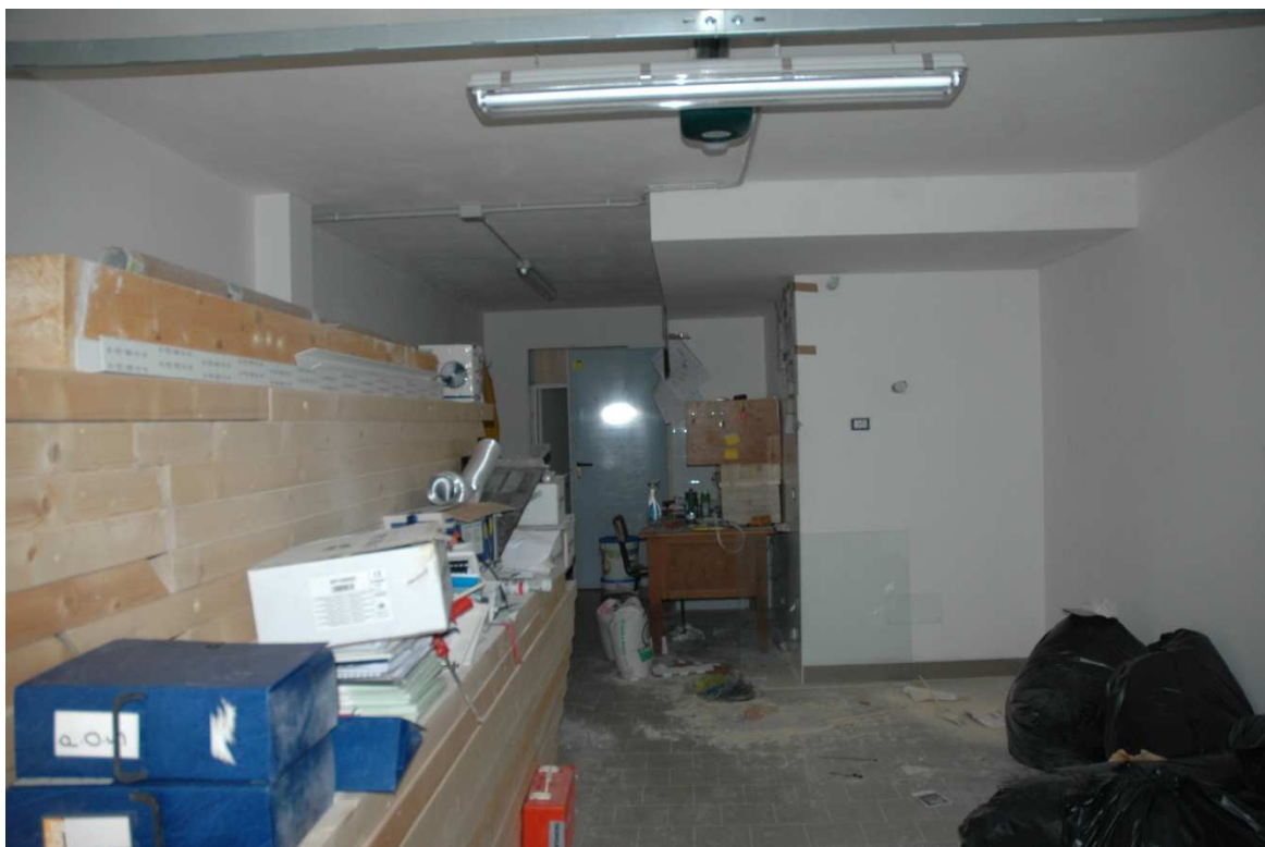
Foto 59 - Nel garage al piano interrato alcuni impianti sono a vista, il pavimento è in gres.
