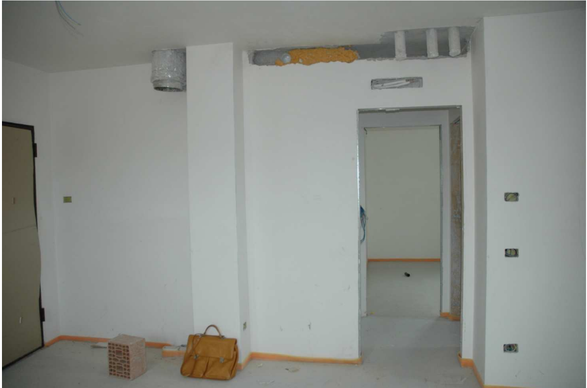
Foto 63 – Il portoncino è del tipo blindato, gli impianti sono da completare.
