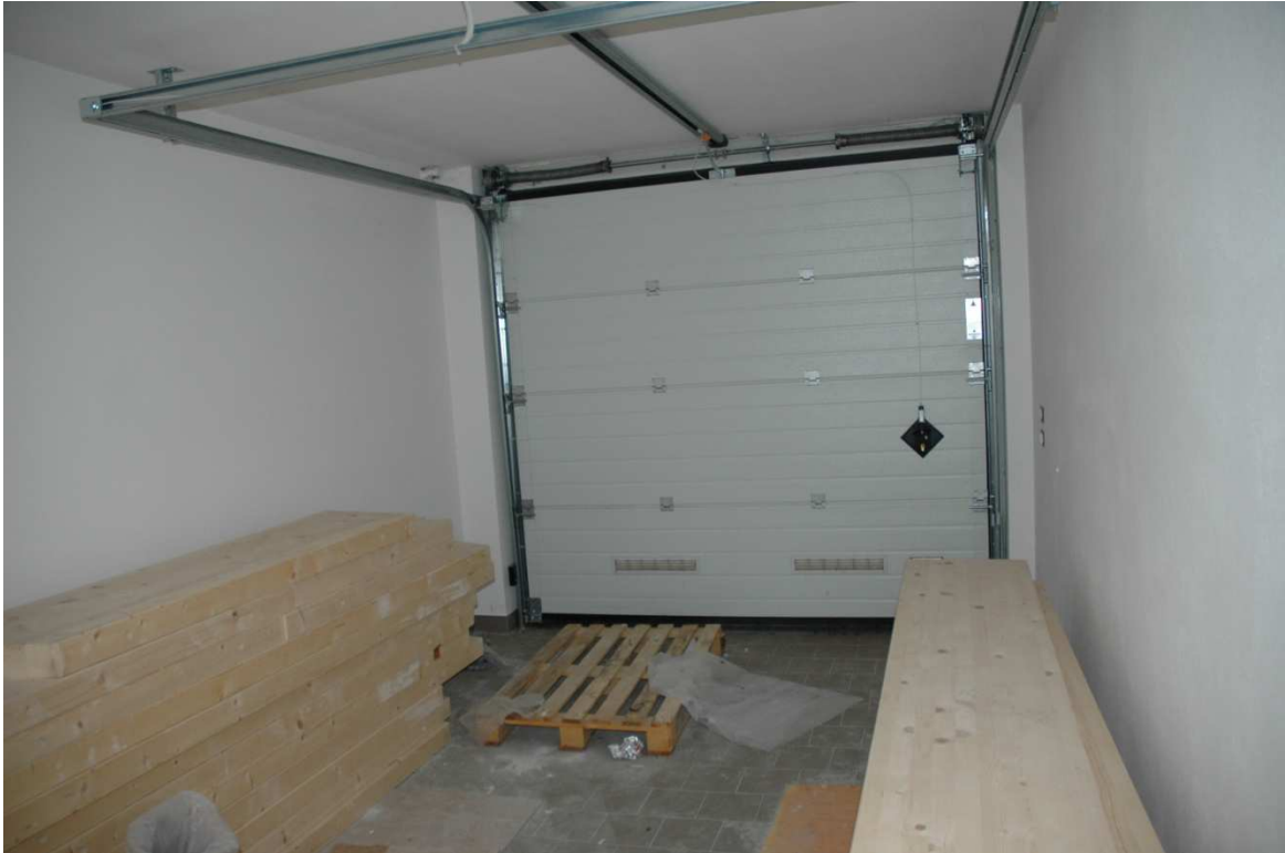
Foto 44 - Garage con porta basculante predisposta per la motorizzazione.
