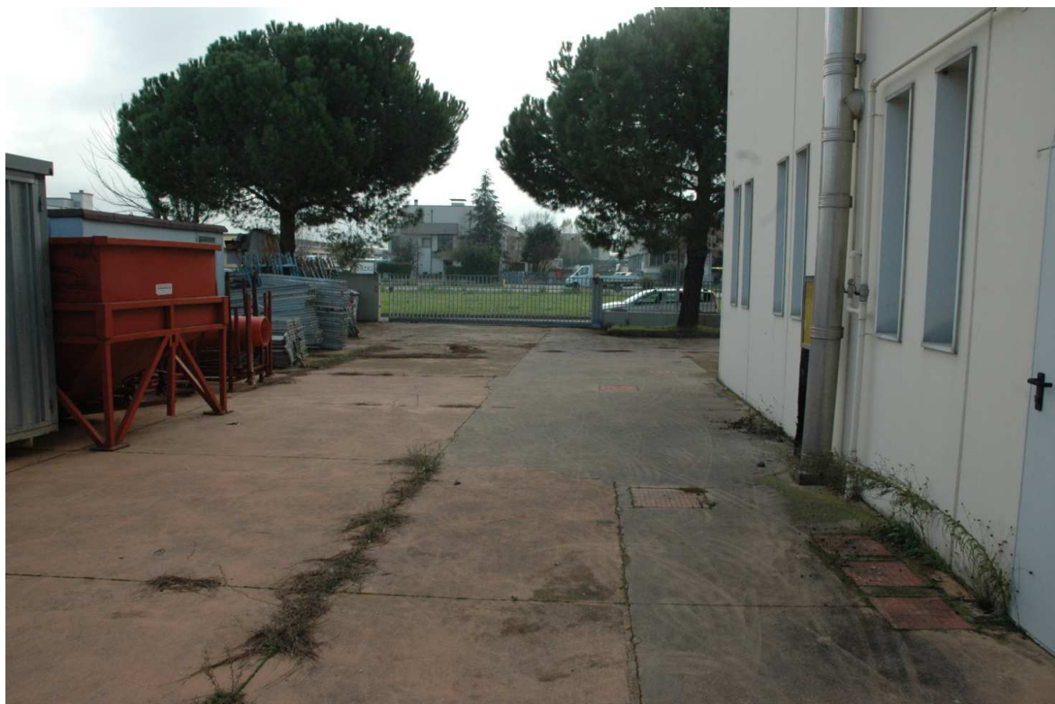
Foto 96 – Corte con pavimentazione in cemento industriale, parzialmente occupata dalle attrezzature della società
