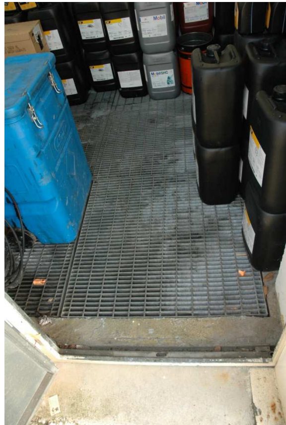
Foto 89 – Locale deposito oli con grata in metallo e raccolta.
