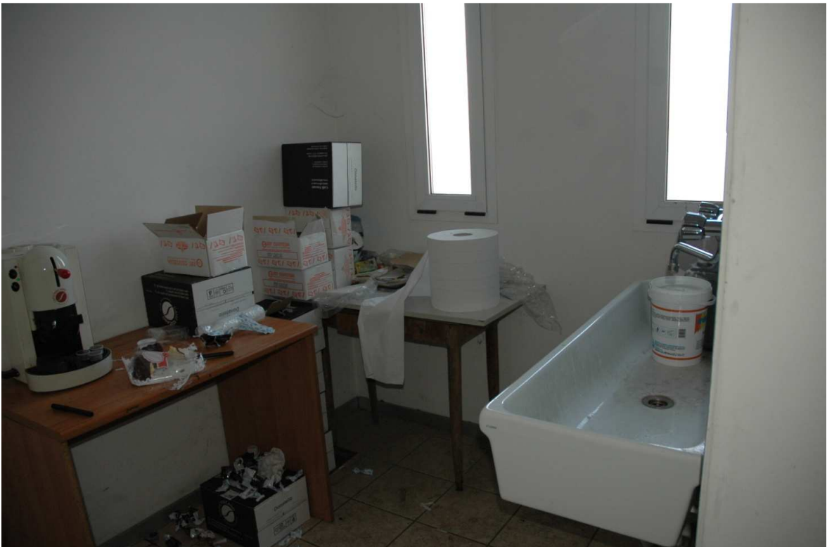
Foto 100 – Servizi e bagni nella porzione del fabbricato in muratura.
